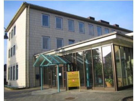
Die Räumlichkeiten der Führungsakademie befinden sich in der Fuhsestraße 30 in Celle
