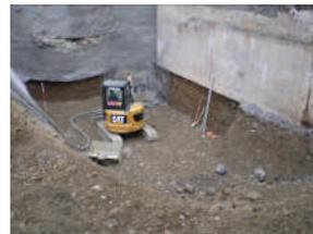
Bei den Aushubtransporten musste großen Wert auf eine maximal Beladung von 11m<sup>3</sup> Aushubmaterial gelegt werden, da die Erfahrungen während der Mauersanierung zeigten, dass bei Beladungen von 12 m<sup>3</sup> und mehr die Herzschlagdetektoren durch die
